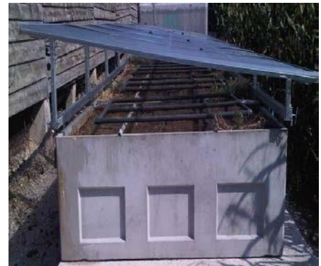
Fig. 2: Sistema Biobac® rivestito in beton e dotato di un tetto trasparente. Fonte: Canton Vaud
